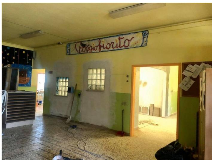
L'ampliamento è stato realizzato demolendo una porzione di parete portante in laterizio pieno tra l'aula e due locali attigui adibiti a deposito.
